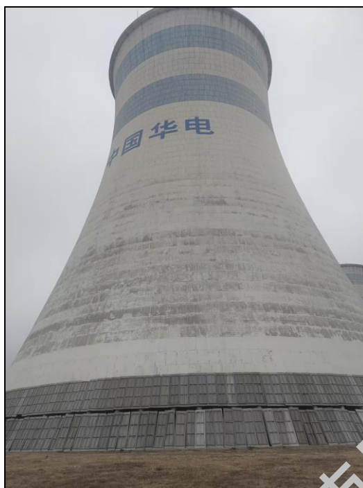
图 3.1.3-4 冷却塔采取声屏障措施
