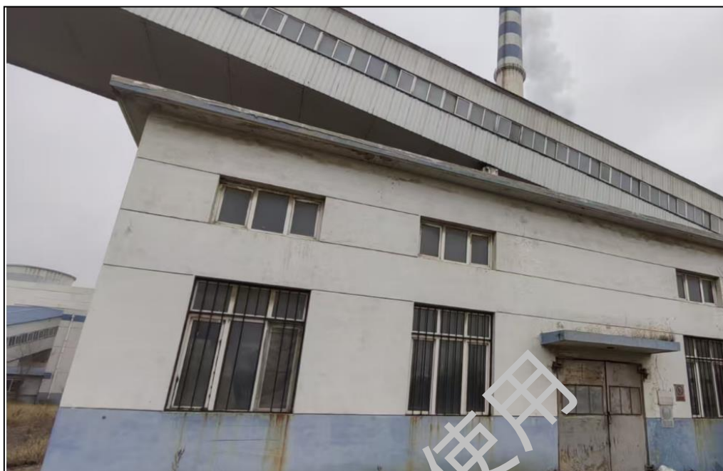
图 3.1.3-3 输煤废水处理站
