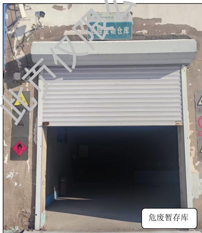
图 3.1.3-5 固废污染防治设施照片
